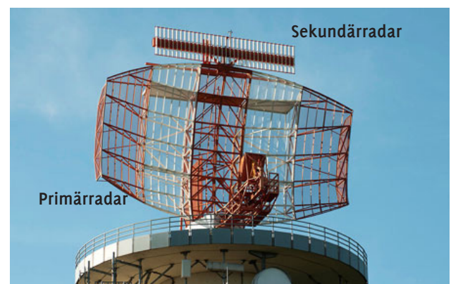
Radaranlage mit Primär- und Sekundärradar Foto: www.dfs.de
